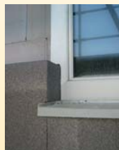
Überdämmung des Rahmens
