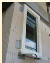
Der Fensterrahmen sitzt vor dem Mauerwerk in der späteren Dämmebene
