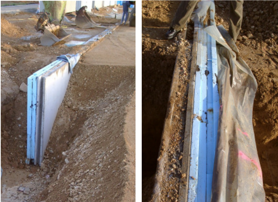
Abbildung 13: Beton mit Dämmschürze, 20 cm Dämmstoff (zweilagig geklebt), vor Erstellung der Bodenplatte (Oktober 2003).
