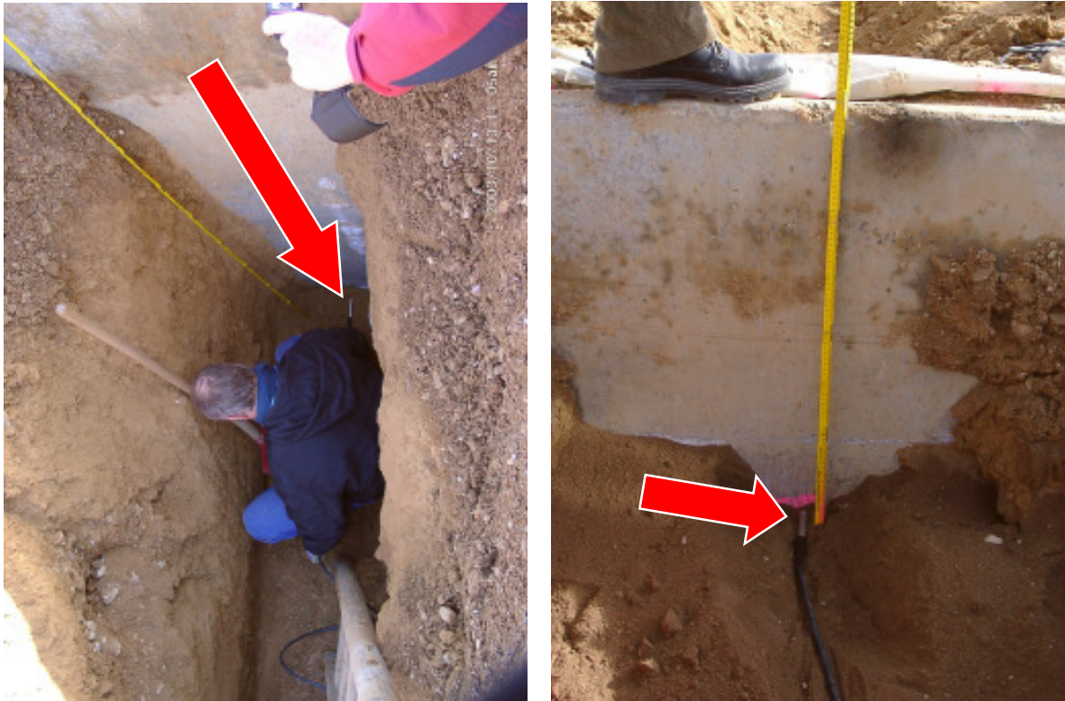
Abbildung 19: Montage der Erdreichtemperatursensoren 2003 (hier in Nähe der Dämmschürze) unter der späteren Bodenplatte in unterschiedlichen Tiefen.
