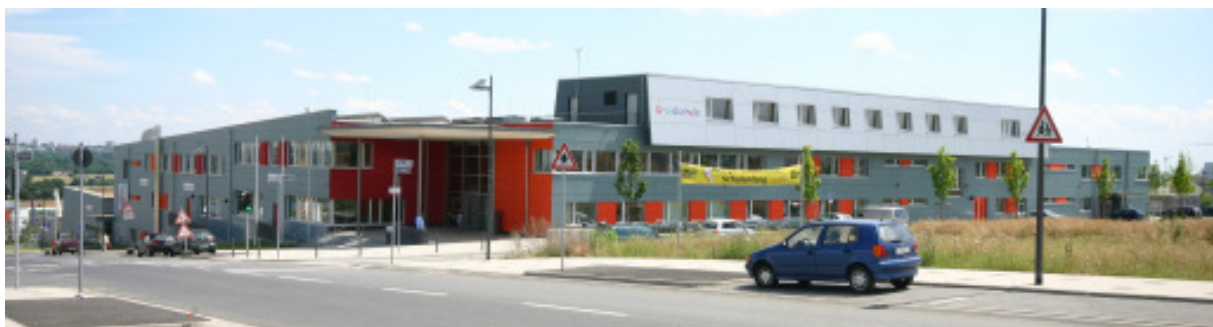
Abbildung 7: Ansicht Nord-West Fassade.
