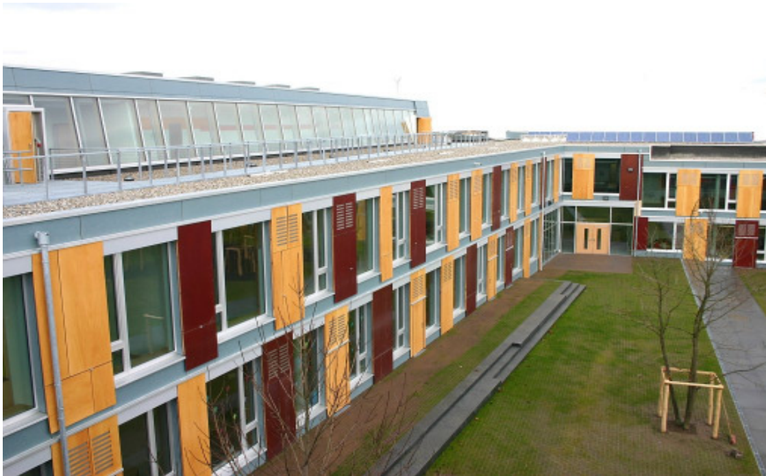
Abbildung 5: Hofansicht von der KiTa in Richtung Norden auf den Schulteil.
