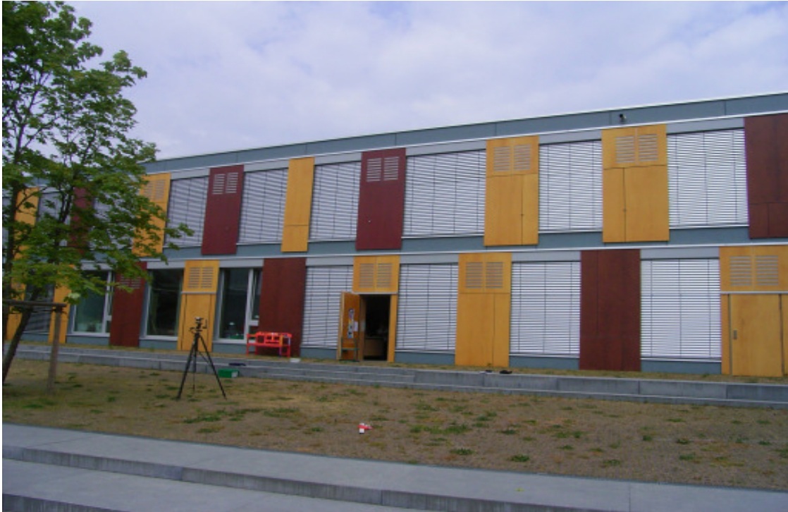
Abbildung 40: Ansicht der Südostfassade zum Innenhof. Die Temperatursensoren T8 bis T10 befinden sich ungefähr im gleichen Abstand vom Gebäude wie das Kamerastativ.
