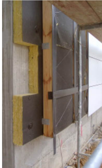
Abbildung 12: Aufbau der vorgehängten Fassade mit zweilagigem Dämmstoff.
