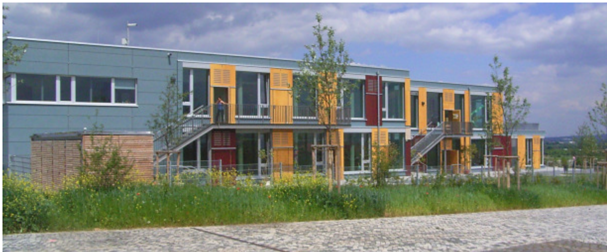
Abbildung 9: Südfassade der KiTa
